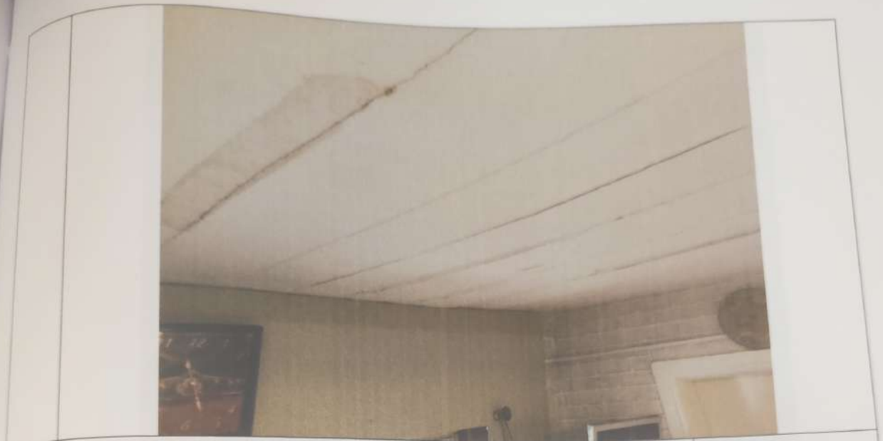
6 Следы протечек в зоне дымовой, вентиляционной трубы. Пятно на площади 300x300 мм 1 этаж. Помещение площадью 6.3 кв.м в старой части здания
