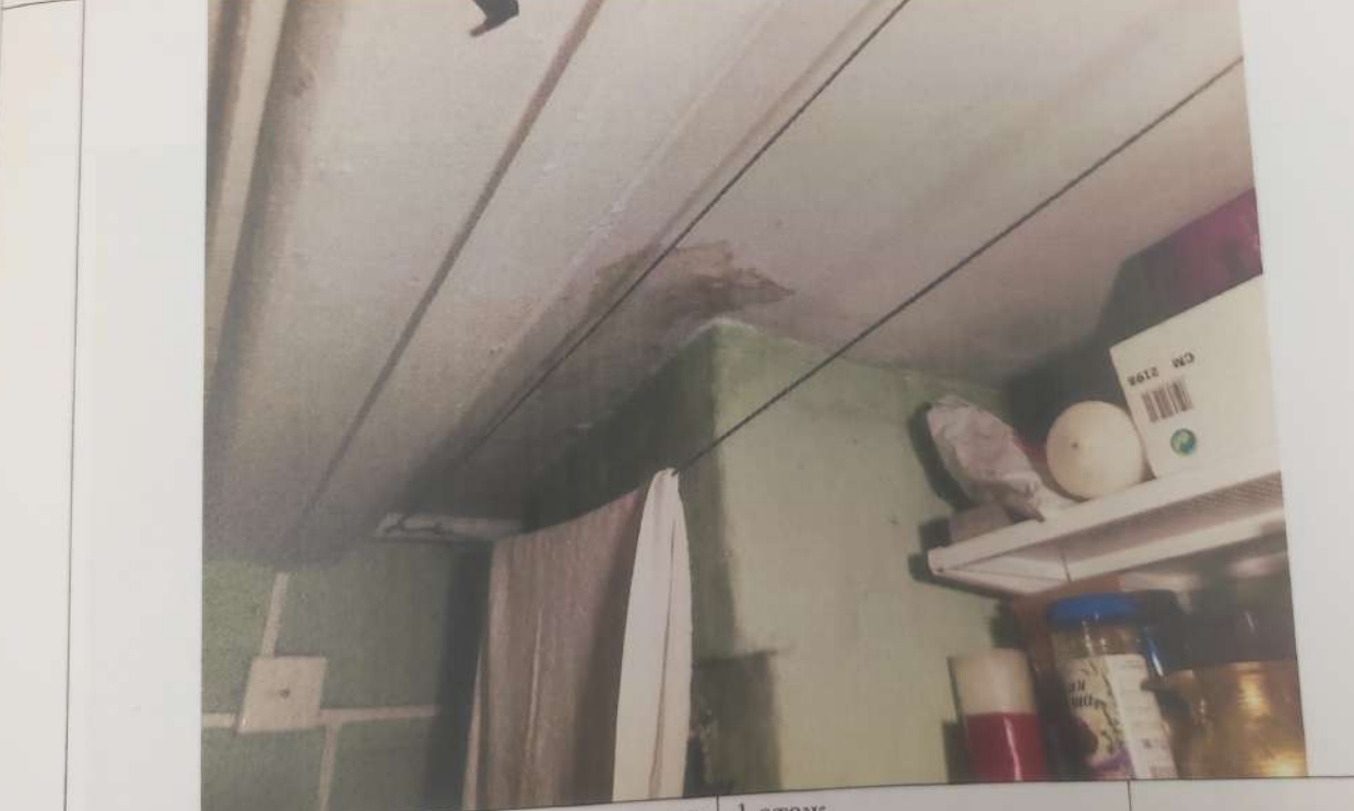
7 Отслоение потолочного плинтуса от основания. Щели от 1 до 3 мм 1 этаж. Помещение площадью 6.3 кв.м в старой части здания
